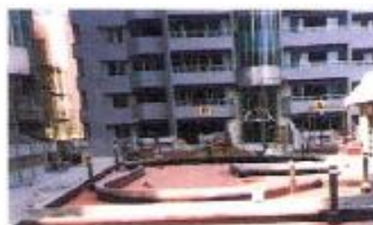
景觀池防滲工程
