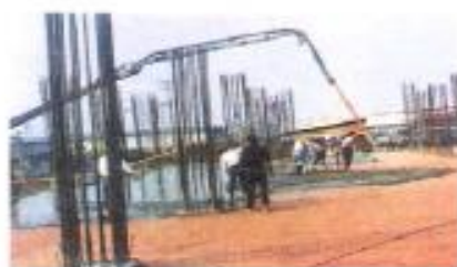
地坪防潮、防水工程
