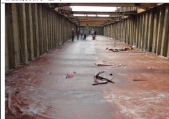
光和材料廠水箱地坪
