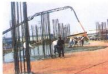
地坪防潮、防水工程
