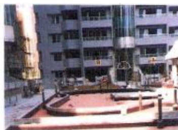
景觀池防滲工程
