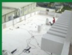
防水布施工後
