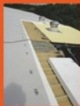
廠房鐵皮屋頂
