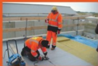
廠房鋼承板屋頂
