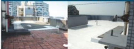
社區大樓屋頂
