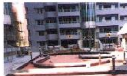
景觀池防滲工程
