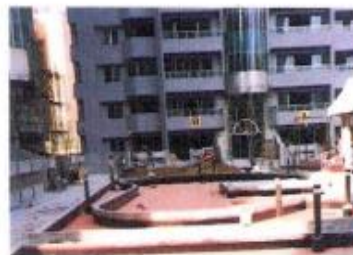
景觀池防滲工程
